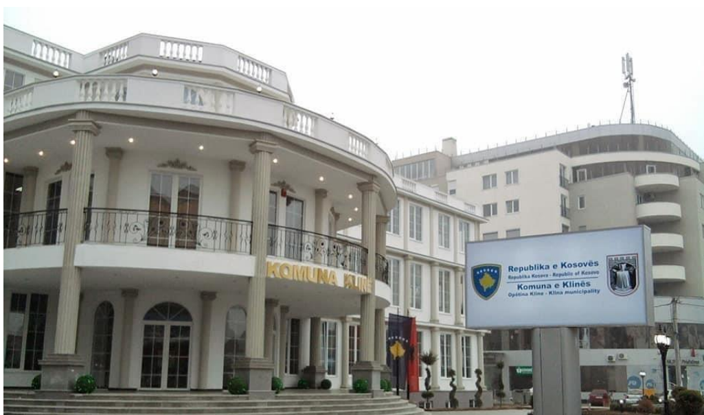
Fotografia 88 Objekti i Komunës së Klinës
