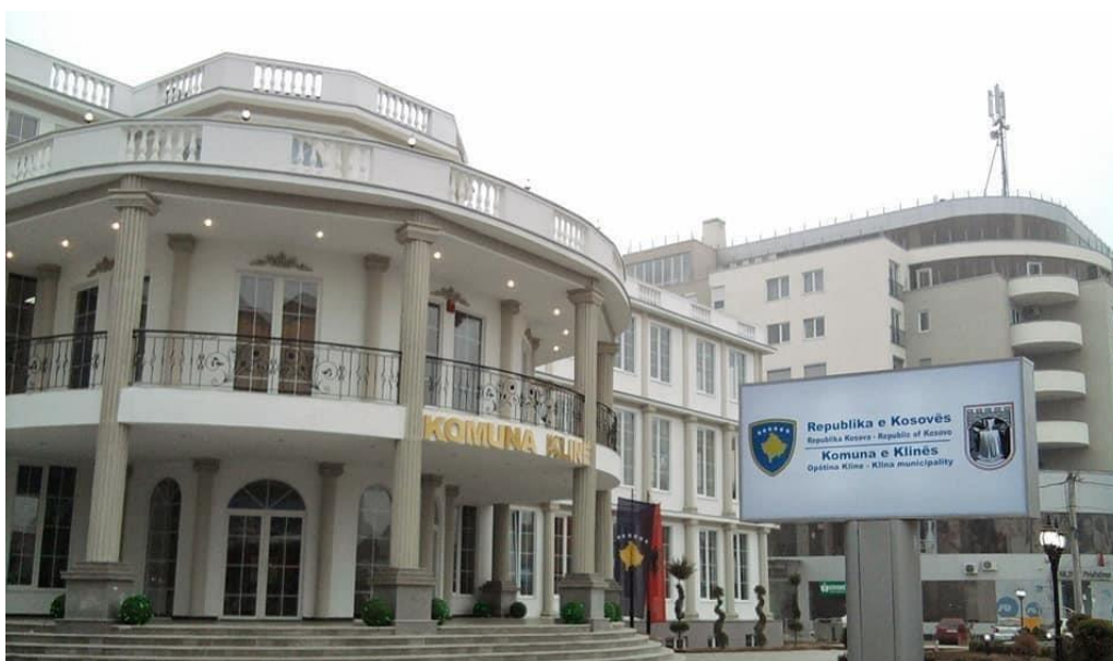
Fotografia 88 Objekti i Komunës së Klinës
