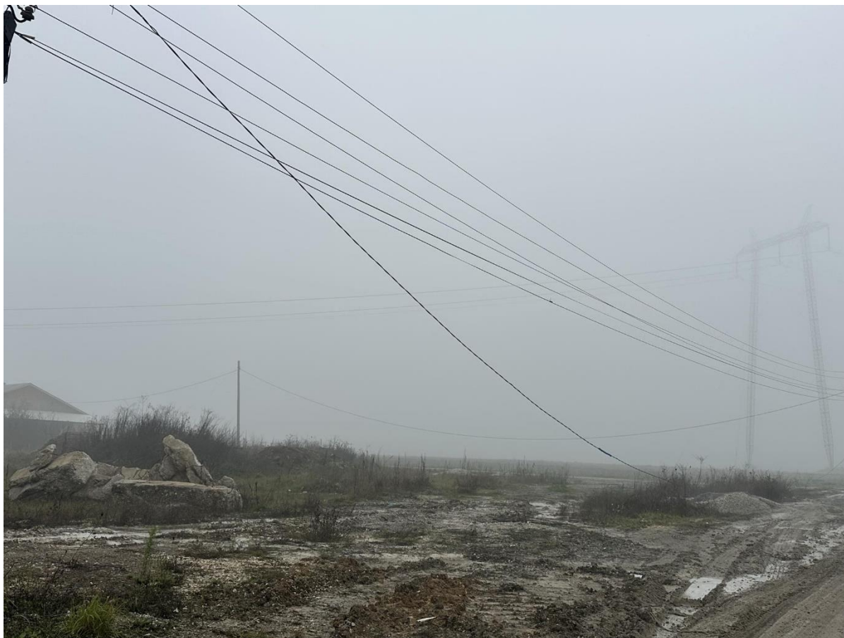
Figura 7. Pamjet në perëndim të bazës për prodhimin e betonit
