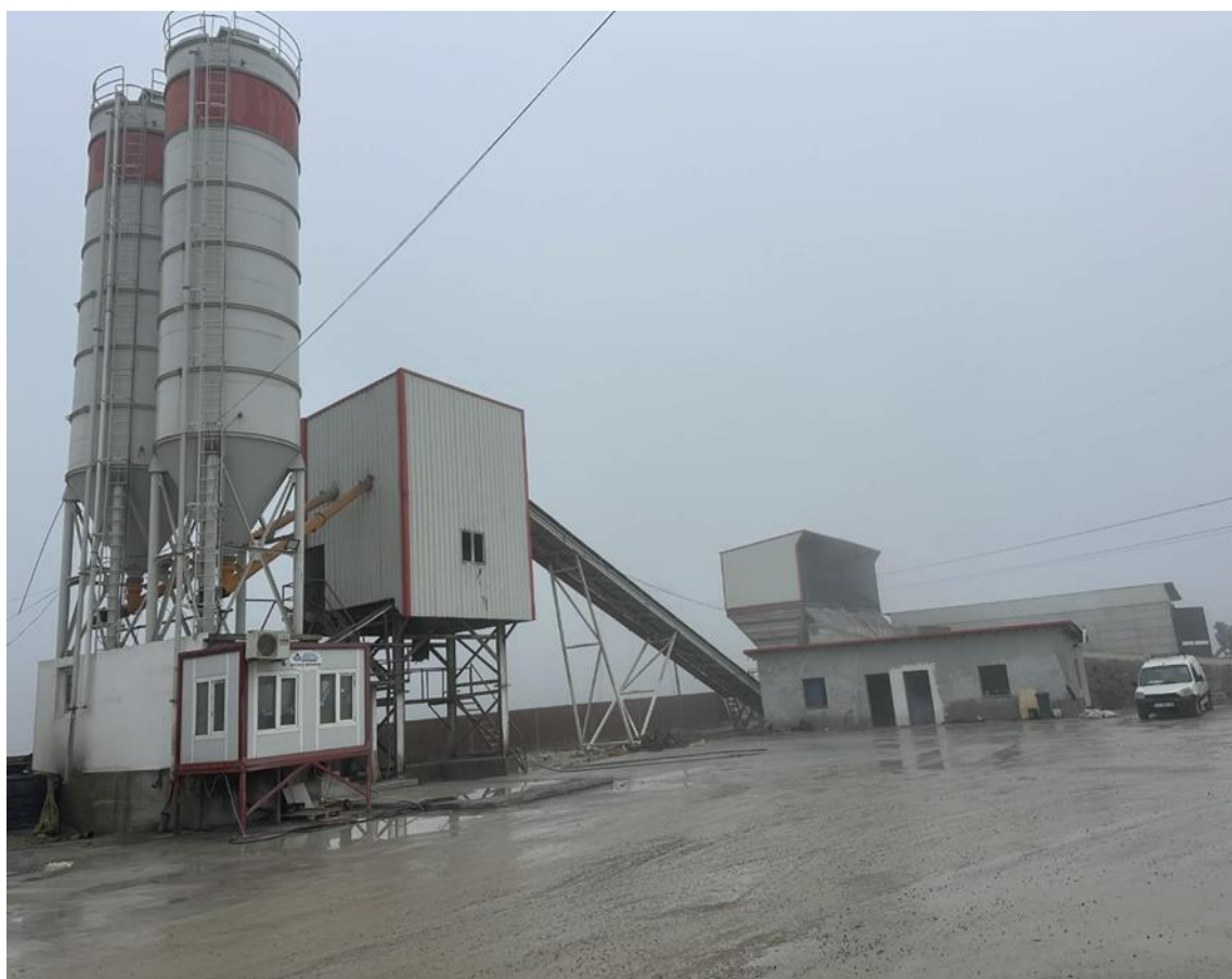
Figura 3. Baza për prodhimin e betonit “Best Beton”sh.p.k. në Milloshevë, Obiliq
