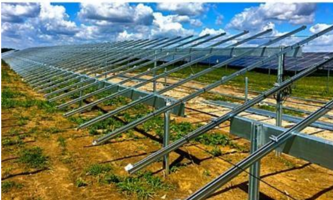
Figura 3. Pamje e Strukturave montuese te PV moduleve djellore
