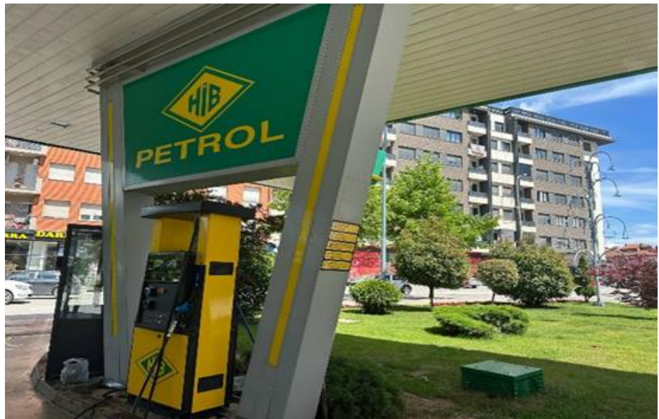
Figura 13Pompa për toçitje të gazit
