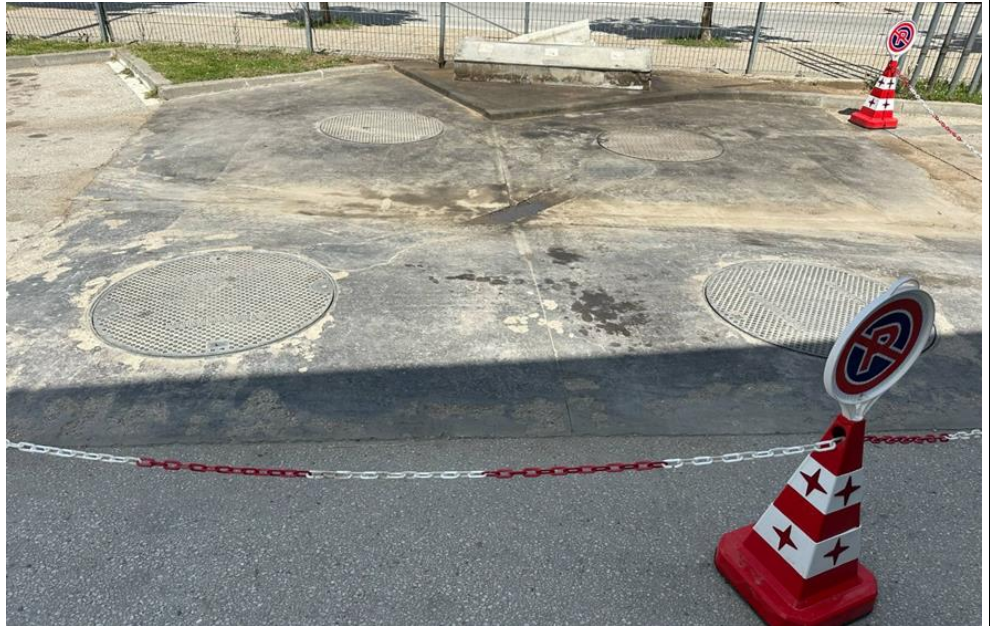
Figura 11. Rezervuarët e naftës dhe benzinës
