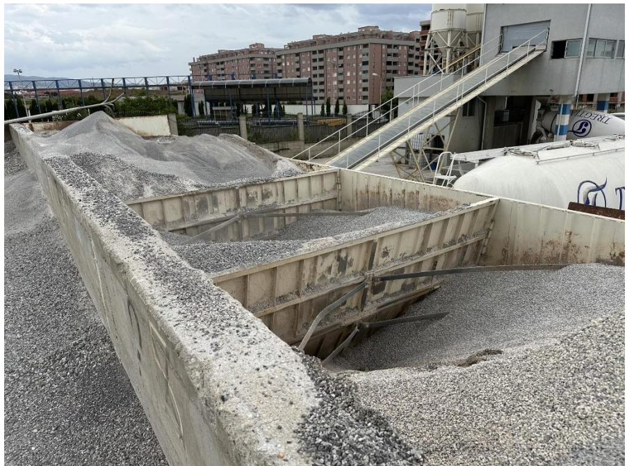
Figura 9. Baza për prodhimin e betonit "TREGTIA" Sh.P.K. Fushë Kosovë, hinkat e lëndës së parë
