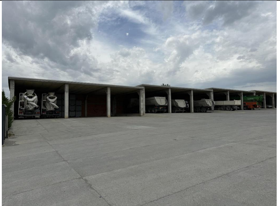
Figura 14. Baza për prodhimin e betonit "TREGTIA" Sh.P.K. Fushë Kosovë, garazhet për automjete punuese
