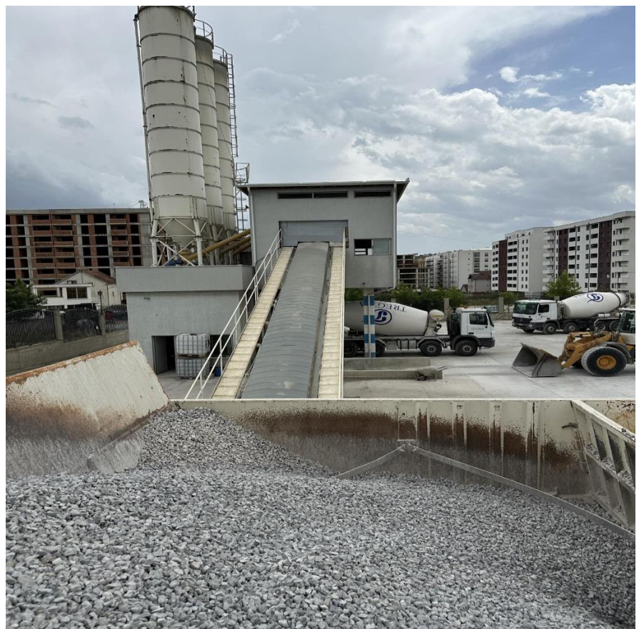
Figura 11. Baza për prodhimin e betonit "TREGTIA" Sh.P.K. Fushë Kosovë, shiriti transportues nga mulliri të siloset
