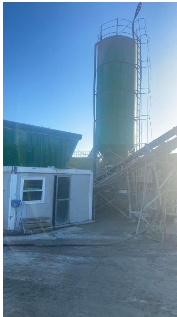
Foto. Pamje e betonares.
