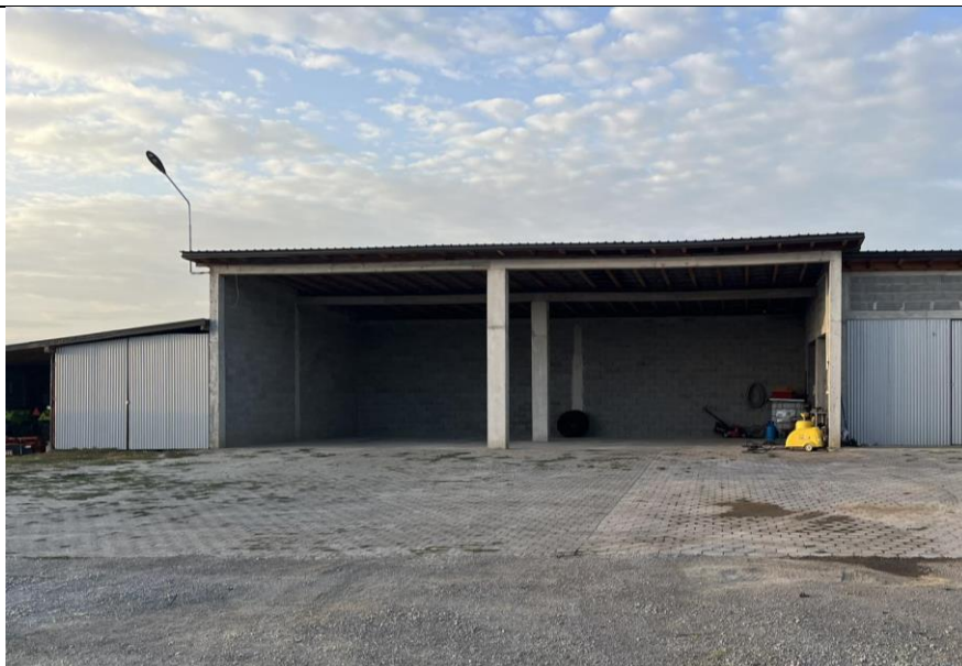
Foto 7. Depoja me rezervuare e shpërndare ne dy rende, objekti ku behet testimi bombolave dhe mbushja automatike e bombolave, pishina me ujë, objekti garazhe dhe depo për mjete të ndryshme.
