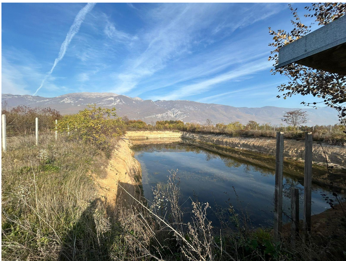
Figura 19. Bazeni për furnizim me ujë në lokacionin e projektit (08.11.2024)
