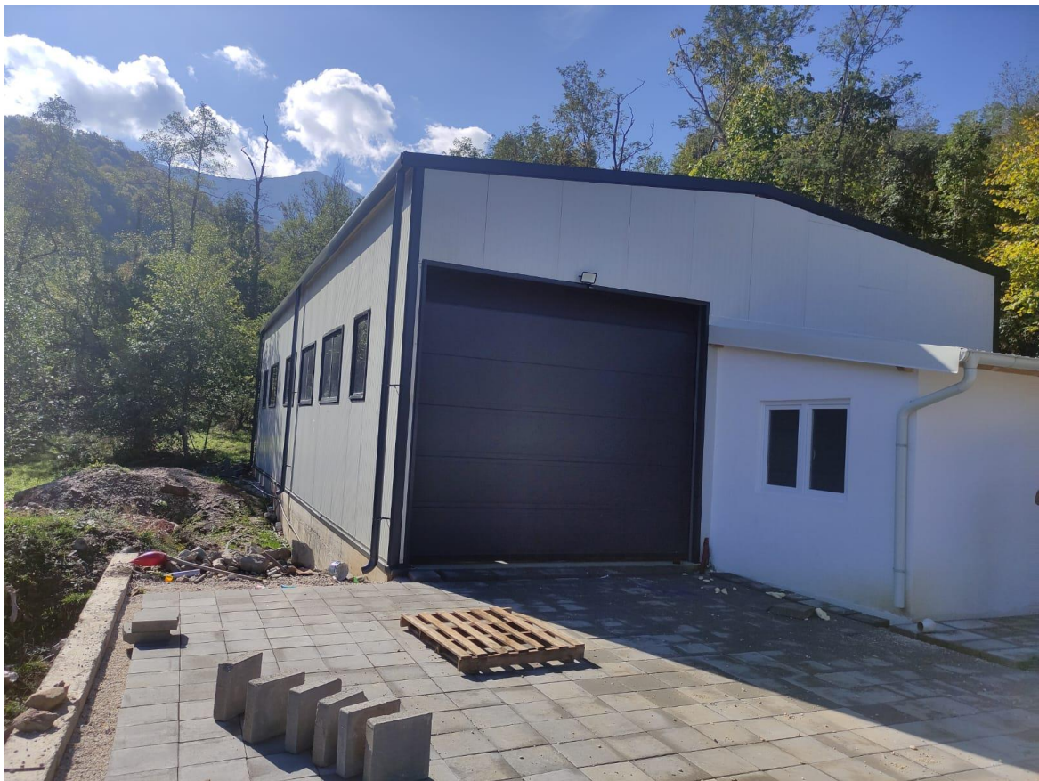
Foto.2. Pamja e Fabrikës për prodhimin dhe ambalazhimin e ujit mineral dhe të gazuar
