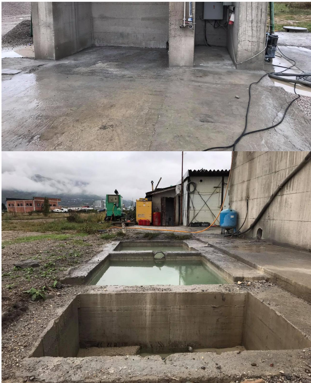
Figura 18. Marrja e masave për minimizimin e ndikimeve ne toke, ku është be betonimi i pllatose.
