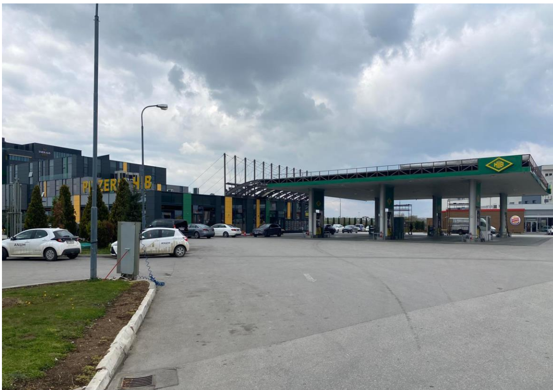
Figura 7. Pamjet e stacionit të karburanteve Hib Petrol në Preoc, Graçanicë
