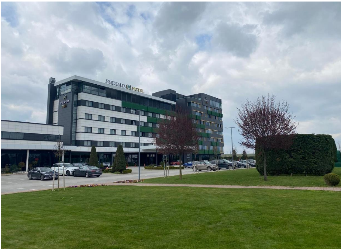
Figura 6. Pamjet në perëndim të stacionit të karburanteve
