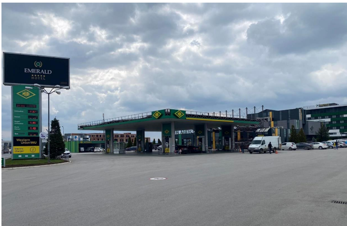
Figura 2. Pamjet e stacionit të karburanteve Hib Petrol – në Preoc, Graçanicë
