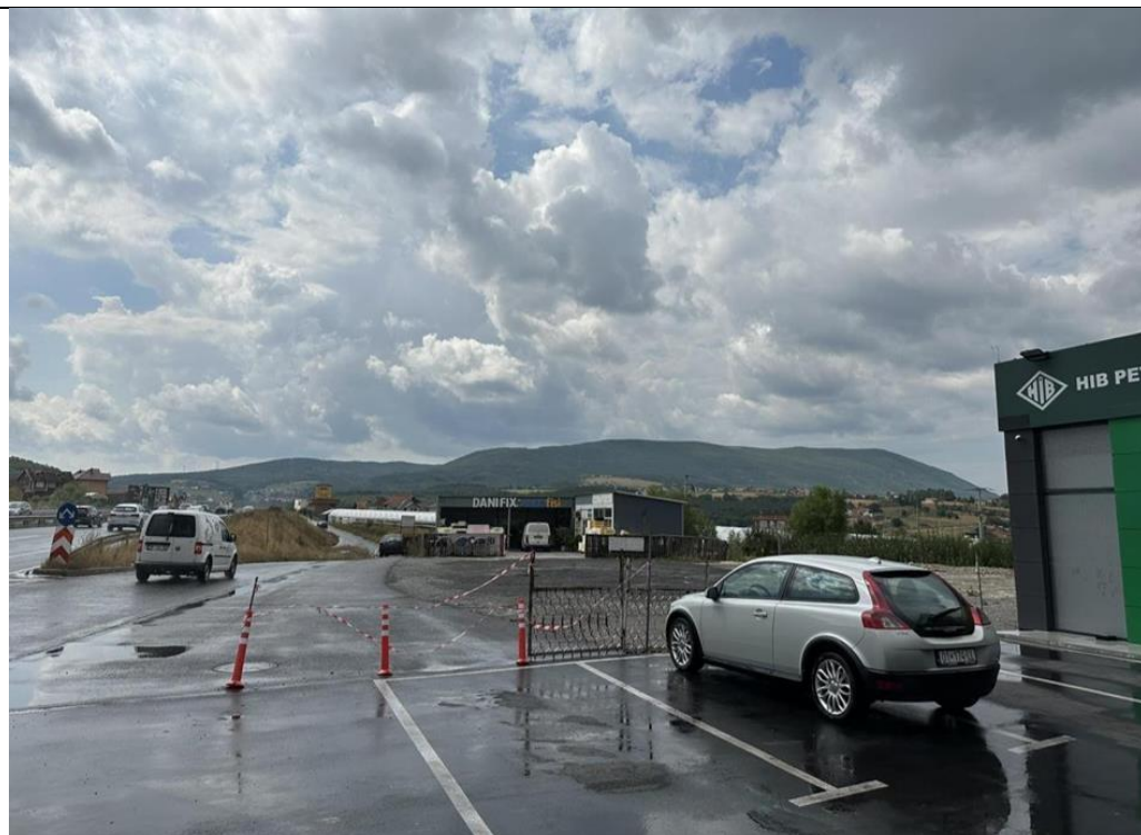
Figura 7. Pamjet në perëndim të stacionit të karburanteve
