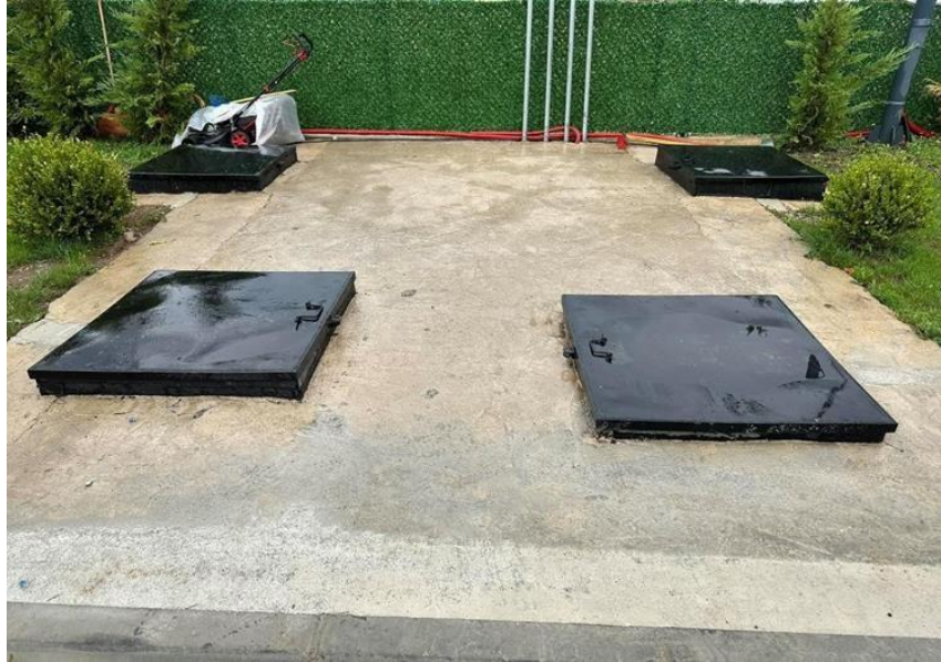
Figura 11. Rezervarët e naftës dhe benzinës
