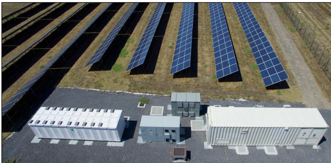
Figura 15. Sistemi i baterive BESS.
