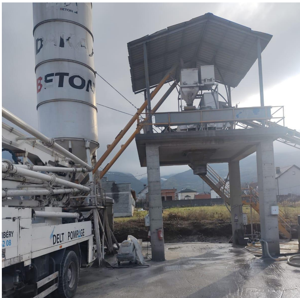
Figura 7. Impianti i prodhimit te betonit dhe elementeve nga betoni FORTESA BETON SH.P.K.
