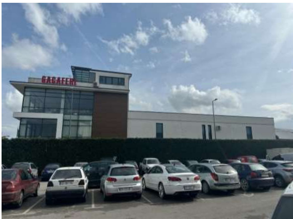
Figura 6. Pamjet në perëndim të stacionit të karburanteve
