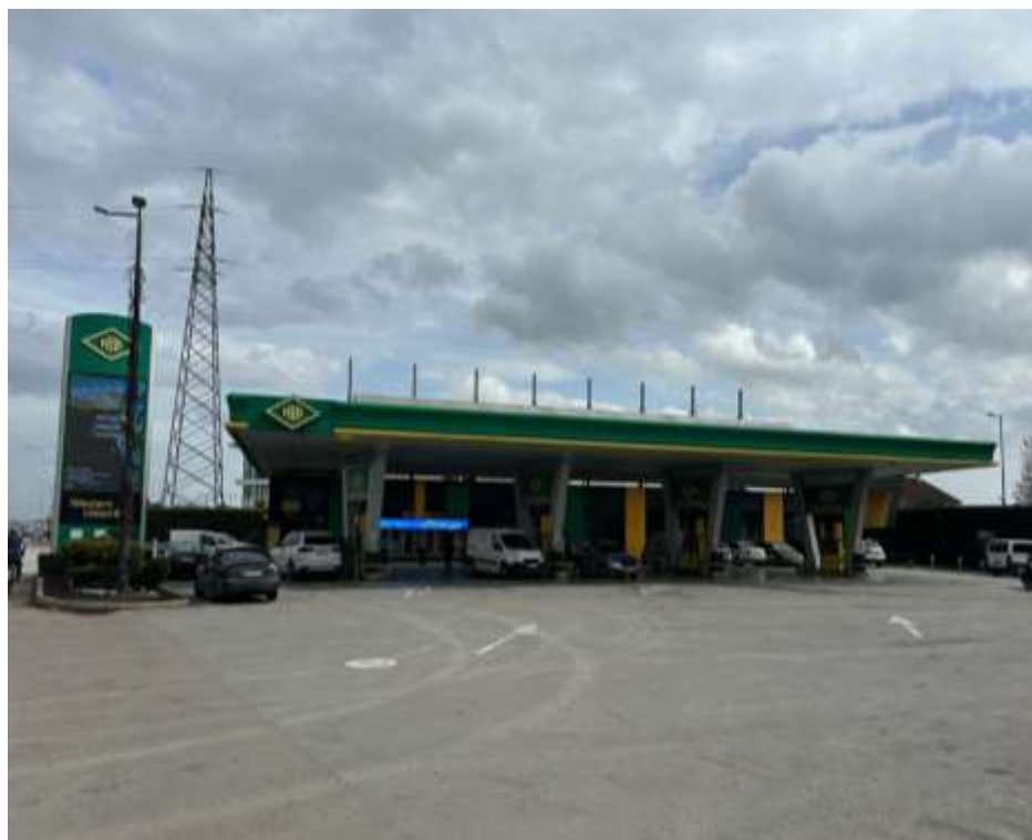
Fig 2. Stacioni i karburanteve "Hib Petrol" sh.p.k. Pejë
