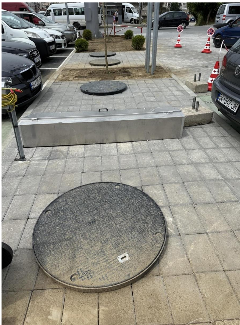
Figura 7. Rezervuarët e naftës dhe benzinës
