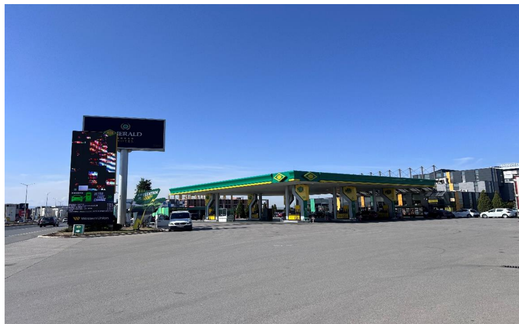
Figura 2. Stacioni i karburanteve HIB Petrol SH.P.K. Preoc – Graçanicë.
