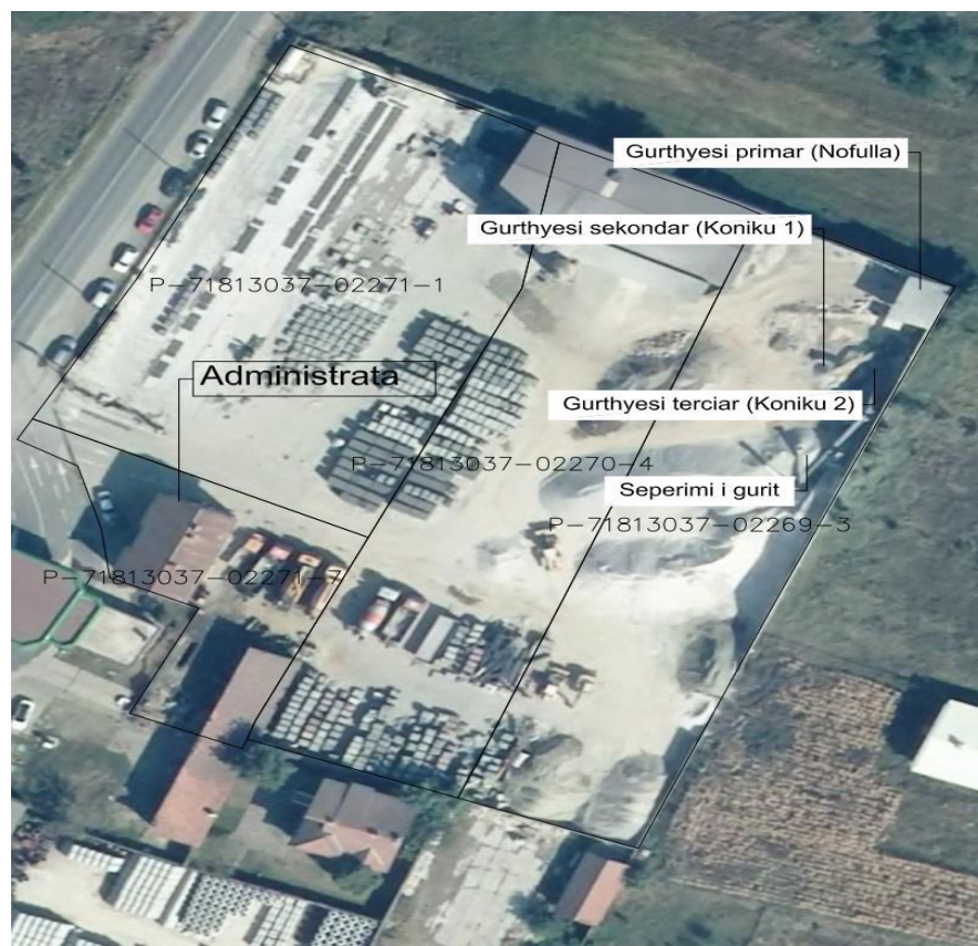
Figura 5. Procesi teknologjik i seperacionit me gurëthyes të kompanisë “FORTESA” sh.p.k
