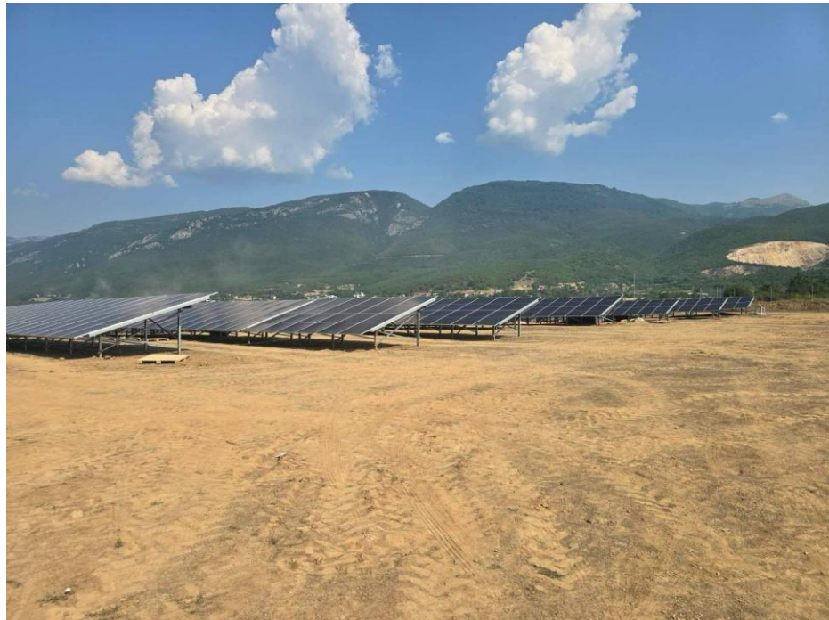
Figura 17 Strukturat metalike të propozuara për projektin solar
