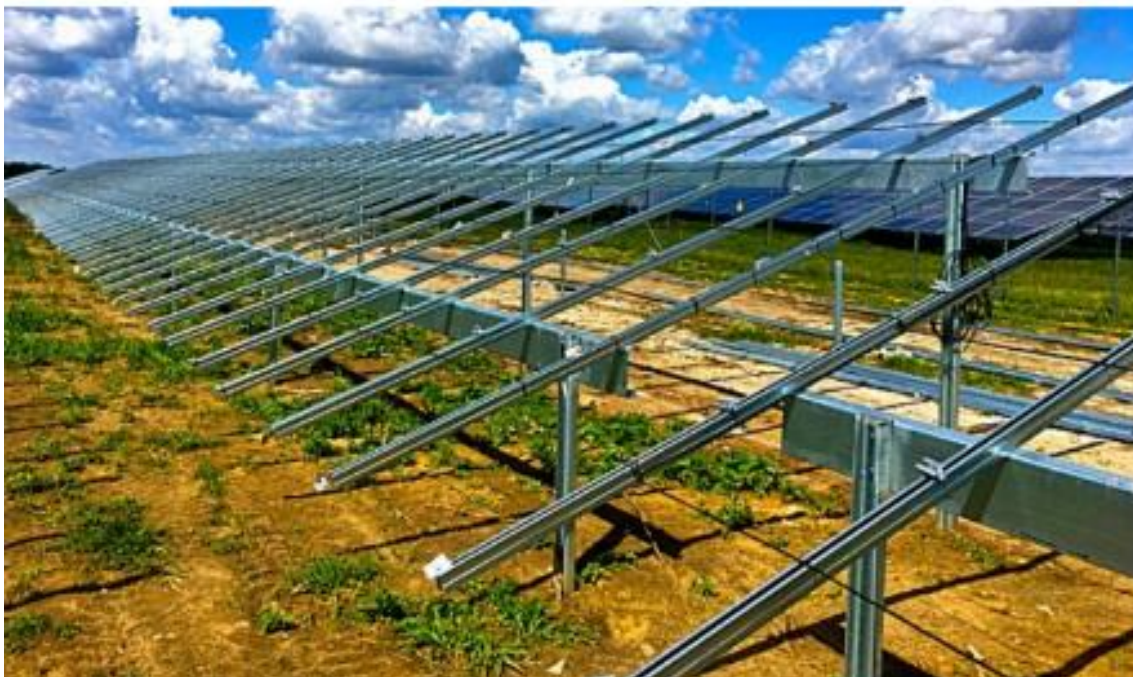
Fig. Pamje e Strukturave montuese te PV moduleve djellore
