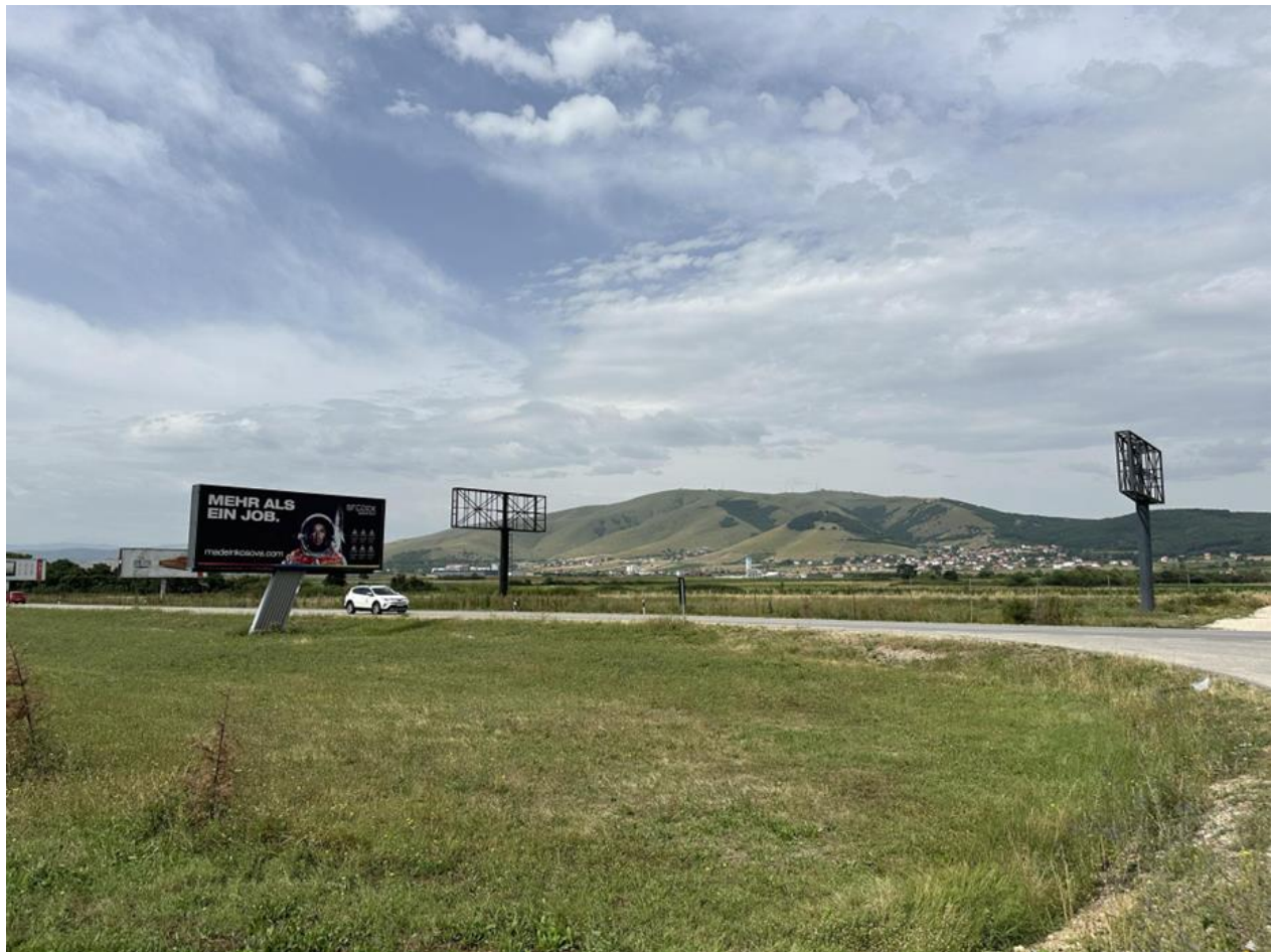
Figura 8. Lokacioni i projektit (rruga) në perëndim të Parkut të energjisë diellore me fuqi 1.948 MW, Sllatinë e Madhe, Fushë Kosovë
