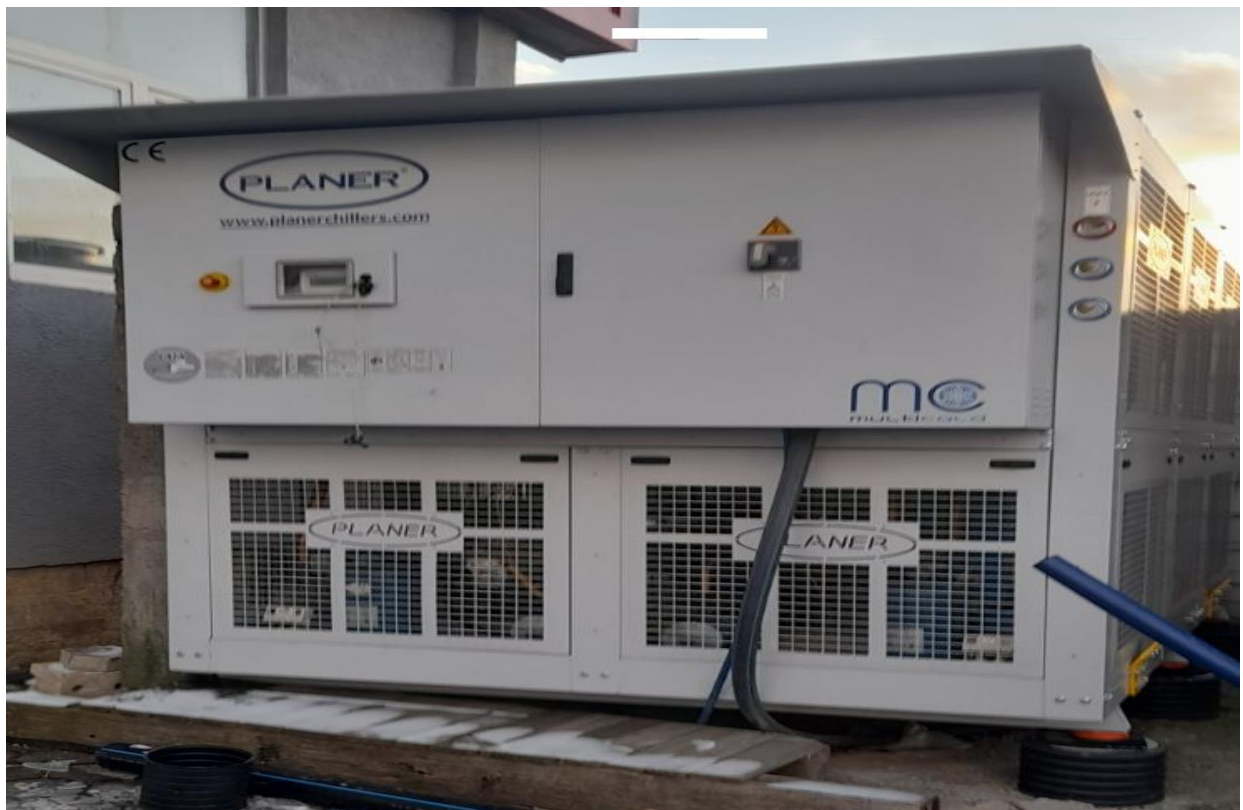
Foto. 12. Pamje e Frigoriferit kryesor për sistemin e ftohjes së ujit, me lëvizje të ujit përmes sistemit të mbyllur
