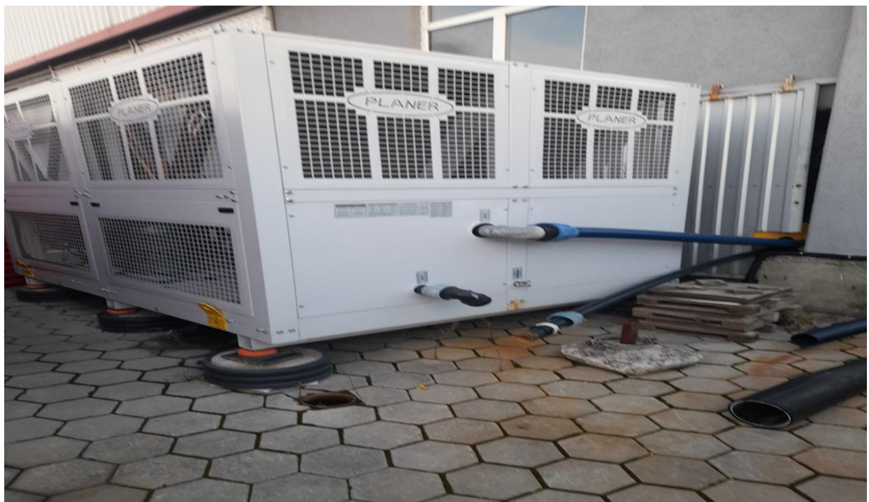
Foto 11. Pamja e Frigorifereve që kanë aplikim për Objektet përcjelëse gjatë procesit teknologjik të prodhimit të tubave të plastikës
