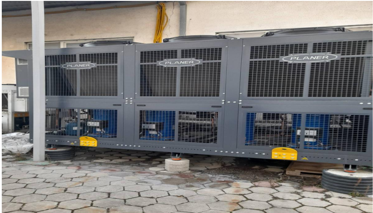
Foto.10. Pamja e frigorifereve në funksion të sistemit ftohës I mbyllur gjatë procesit teknologjik .
