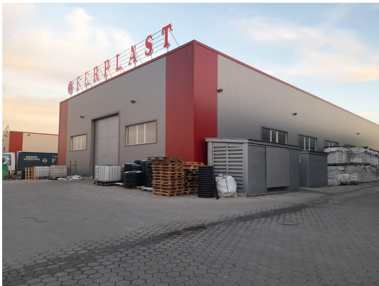
Foto 1. Pamja e Objektivit për prodhimin e tubave të plastikës , Objekti i planifikuar për ndërtim në kuadër të Kompanis NPT” Ferplast”
