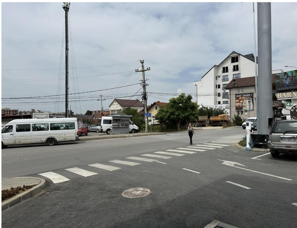
Figura 3. Pamja në veri të stacionit te karburanteve "Hib Petrol" sh.p.k. Prizren (3)
