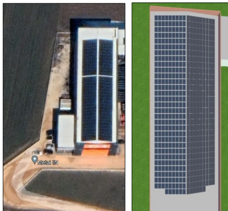
Figura 5 Panelet e vendosura mbi objekt
