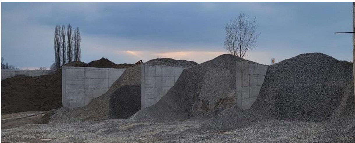
Figura 9 Vendosja e fraksioneve të zhavorrit në afërsi të Impiantit të prodhimit të Betonit
