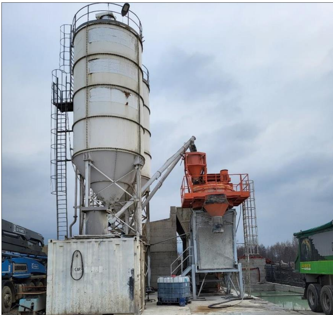
Figura 7 Impianti i prodhimit të betonit dhe elementeve të parafabrikuar nga Betoni " B FABIS" SH.P.K.
