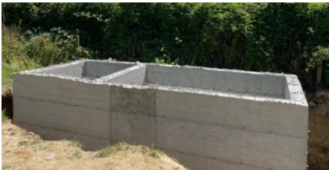
Figura 23. Skema e trajtimit te ujërave (kjo skam është ndërtuar tani).
