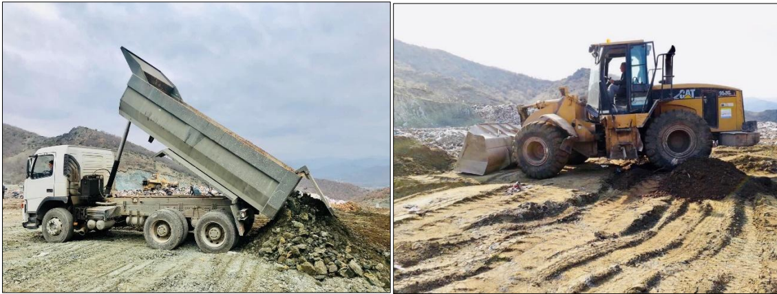
Figura 9 Mbulimi i mbeturinave dhe rere dhe zhavor - rehabilitimi i zonës së Deponisë në vitin 2022
