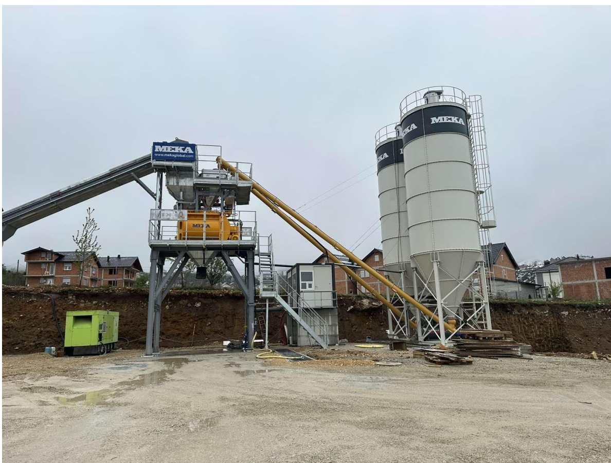
Figura 5. Pamje e betonares e cila është duke u ndërtuar.
