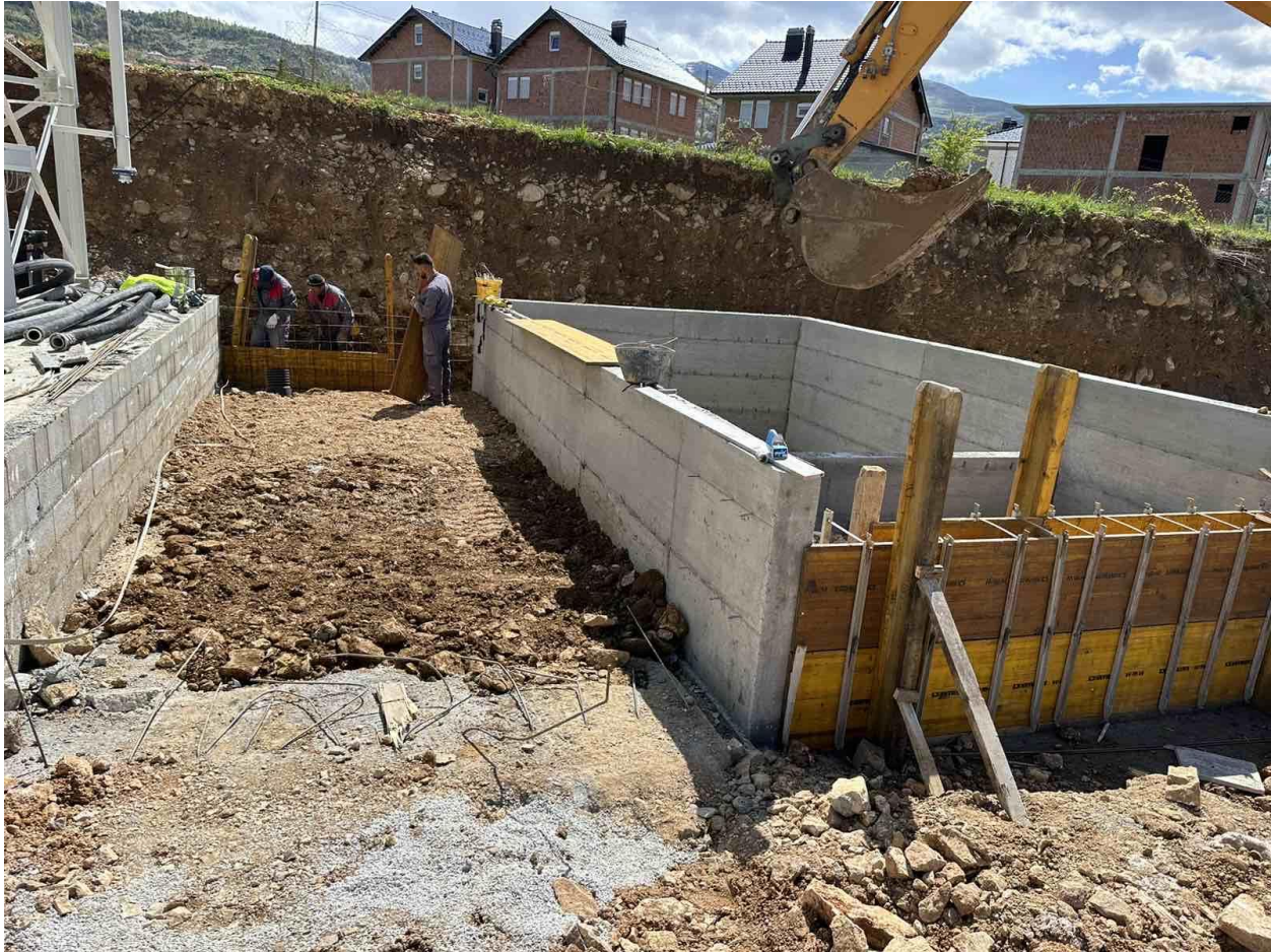
Figura 10. Ndërtimi i gropës sendimenuese për fundërrimin e ujërave që shkarkohen nga impianti, për parandalimin dhe zoogëlimin e ndikimeve negative në ujëra.
